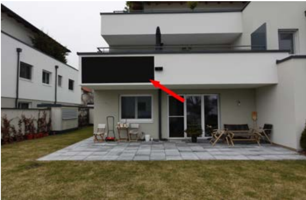
Abbildung 2: Anbringungsposition der steckerfertigen Kleinststerzeugungsanlage an der Fassade
