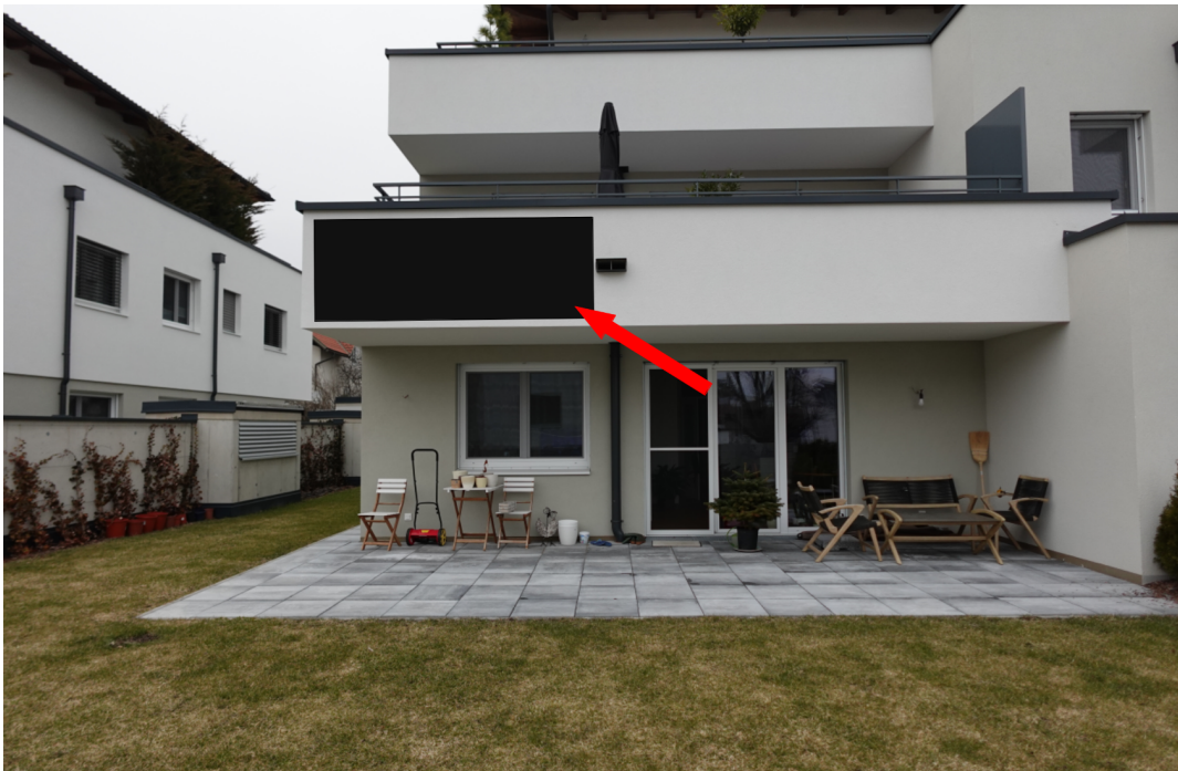
Abbildung 2: Anbringungsposition der steckerfertigen Kleinsterzeugungsanlage an der Fassade
